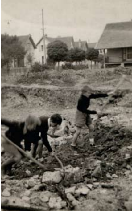
Belfort, Pépinière, vers 1951 : terrassément; petits et grands bénévoles.
