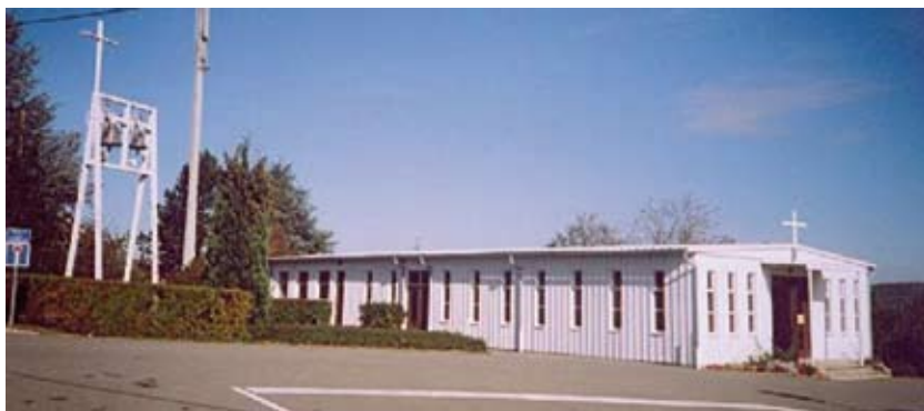
Nommay (25) : chapelle en éléments préfabriqués (de type Fillod), avec un clocheton métallique ; état 2006.
