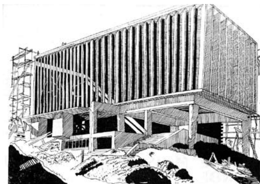
Belfort, Pépinière : église Sainte-Jeanne-d'Arc (M. Lods) en chantier ; dessin de l'abbé Jean Garneret.
