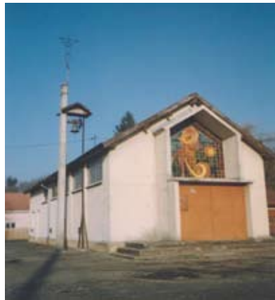
Arbouans (25) : chapelle construite en 1951, près des usines.
