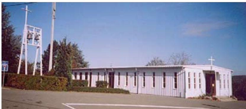
Nommay (25) : chapelle en éléments préfabriqués (de type Fillod), avec un clocheton métallique ; état 2006.
