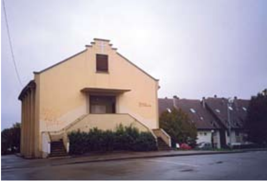
Chapelle catholique (construite en 1954); (état 2005).
