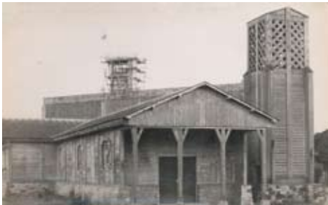
Belfort, Pépinière : baraque de bois provisoire après les bombardements de 1944, avec un clocher en bois. À l'arrière-plan, à gauche, l'église de M. Lods est en cours de construction.
