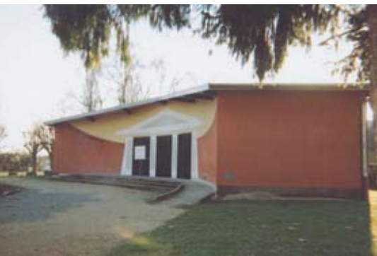
Belfort, Pépinière : ancien temple luthérien Saint-Paul (J. de Montmollin, 1959) : racheté par la Ville de Belfort en 1996 et devenu théâtre des marionnettes (état 2006) 62 .
